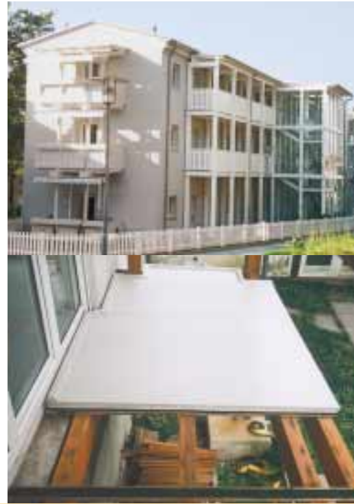
Abb. 44, 45: Balkonanlage mit Balkodur® Platten als tragende Platte
