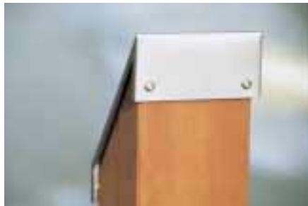
Abb. 3: Hirnholzabdeckung eines Pfostens
