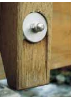
Abb. 5: Einlassen der Unterlegscheiben an einem Pfostenanschluss
